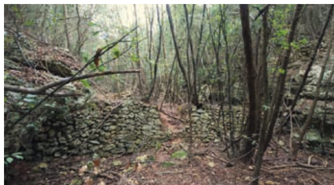
Muro di fascia ortogonale alla valle
