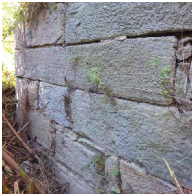
Il muraglione che fungeva da spalla
