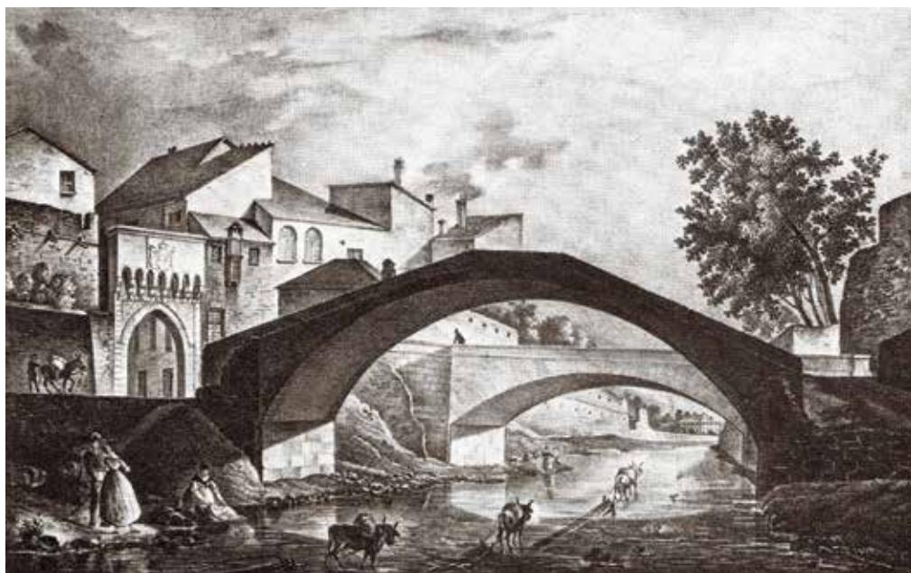
Il ponte a schiena d'asino di Porta Testa edificato ai primi del '700 e demolito verso il 1840
