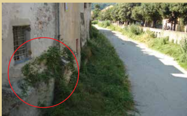
Spalla dell'antico ponte "dei pesci" a Porta Reale
