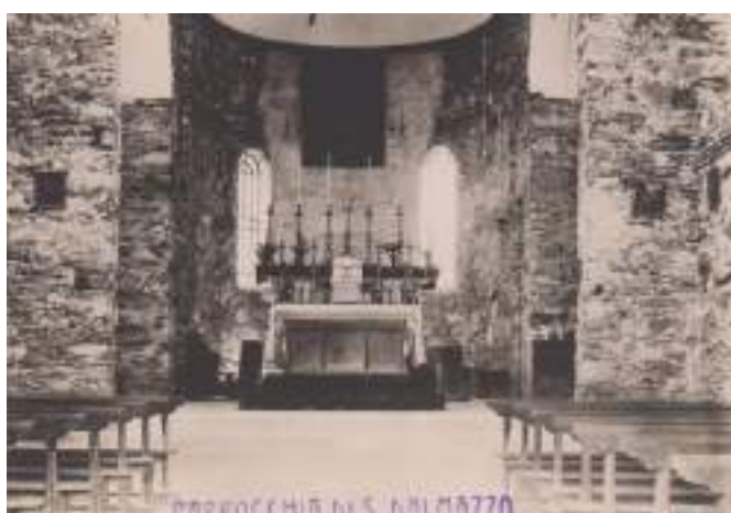
La nuova chiesa appena ultimata e sprovvista di intonaco (Coll. A. Narice)
