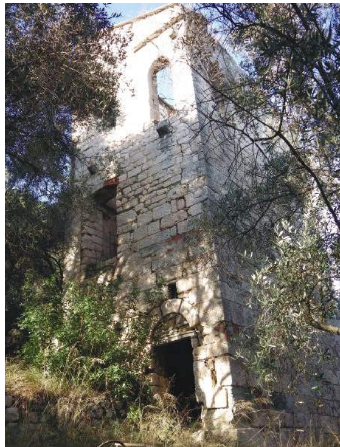
La Torre ormai sommersa dalla vegetazione
