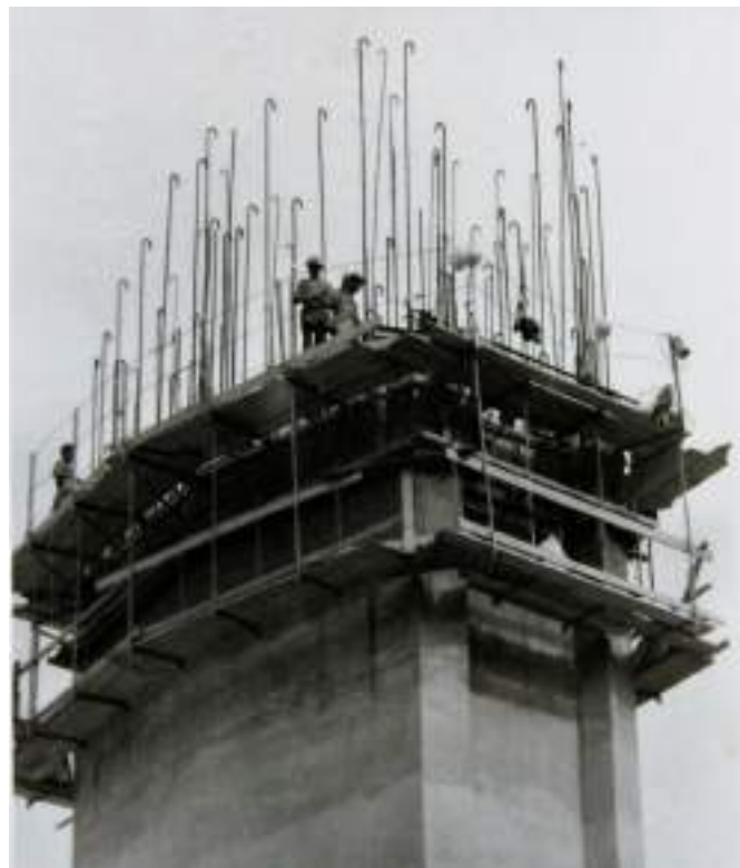
Il ponteggio che "seguiva" il pilone mentre questo si elevava
