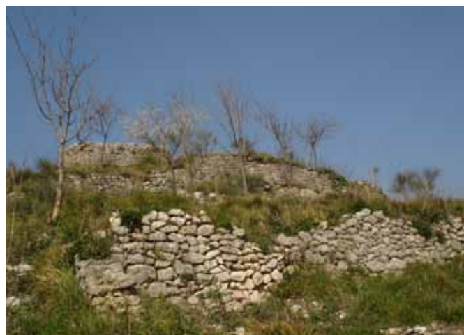
Resti alla base della torre
