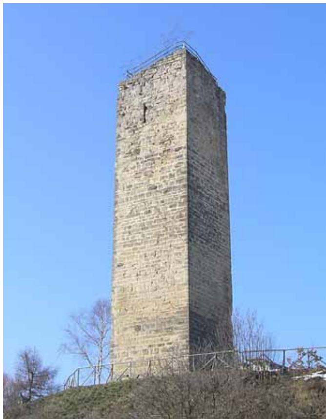
La torre di Castelnuovo di Ceva. A lato: rilievi tecnici della torre a cura del Geom. Fabio Bianchino
