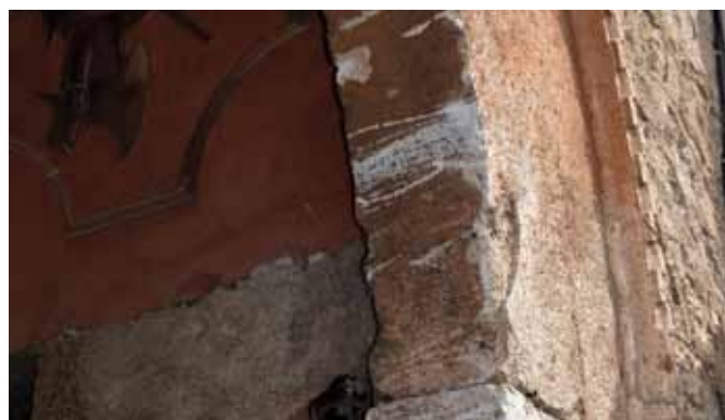
Particolari dello stato attuale di porta Testa
