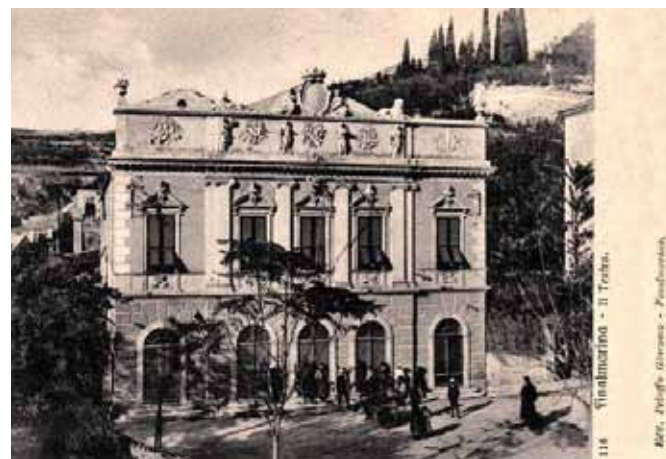
La facciata del teatro Sivori in un'immagine d'epoca
