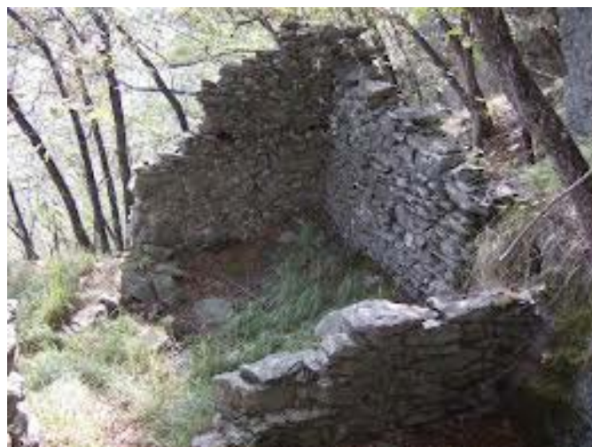
Rudere di costruzione asservita alla miniera
