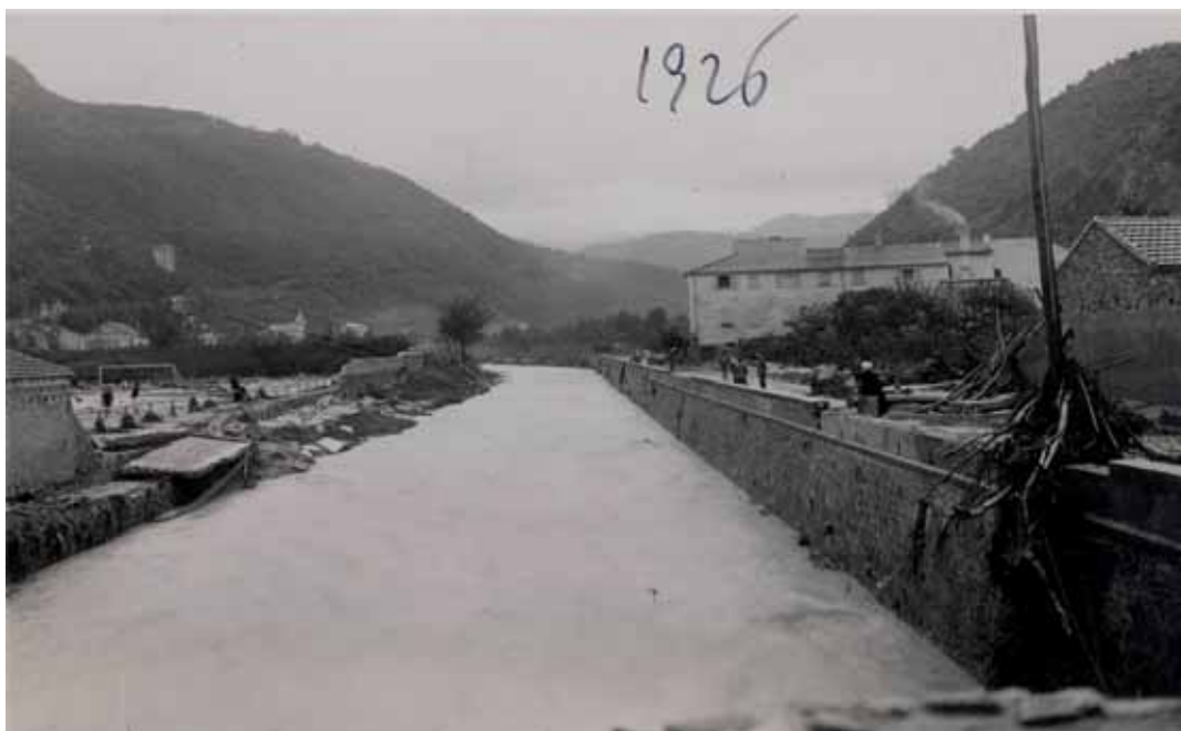
Veduta dal ponte di Porta Testa a Finalborgo dopo l'alluvione del 3 settembre 1926.
