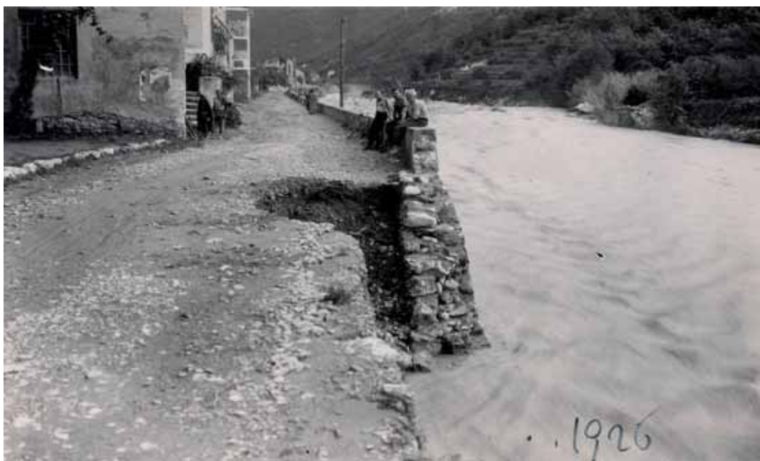
La strada per Calice Ligure distrutta dall'alluvione del 3 settembre 1926
