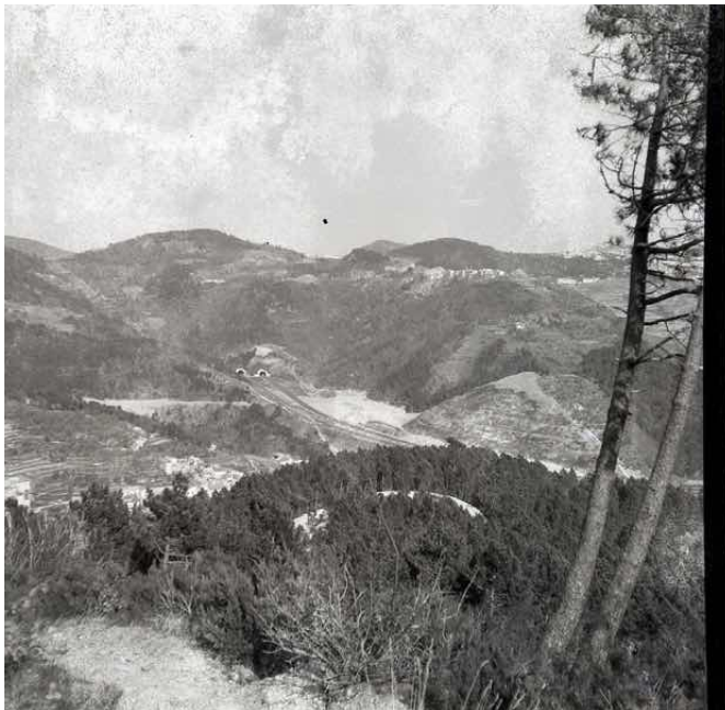
Feglino interessata dal cantiere dell'Autostrada (foto Barbagianni, Banca delle immagini, Palazzo Ricci – Finalborgo)
